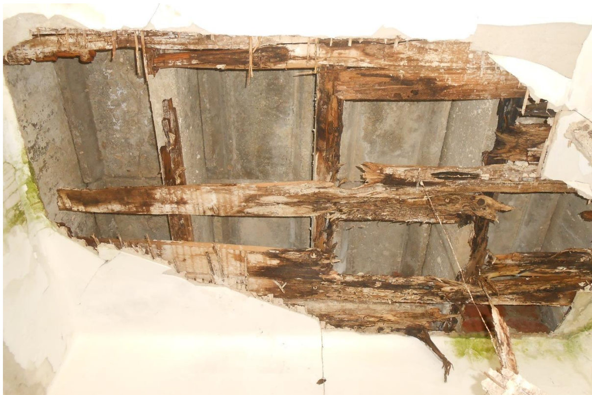
Slika številka 3: zasnova medetažne konstrukcije (fotografija posneta na mestu odpadlega spodnjega sloja v stavbi številka 914)
